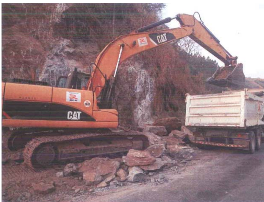
Foto 4 – Desmonte de Rocha a Frio para Melhoria de Geometria - Km 132,5 [1]
