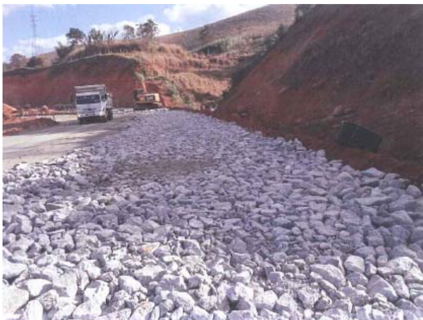
Foto 7 – Adequação da Interseção Cordeiro A - 123+300 [2]
