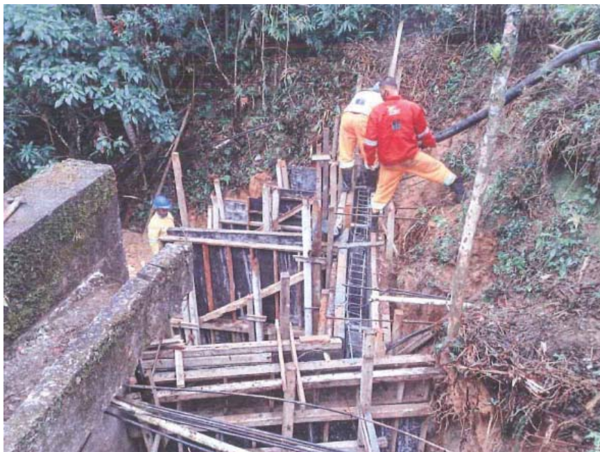
Foto 2 – Ampliação do Sistema de Drenagem - Km 63,5
