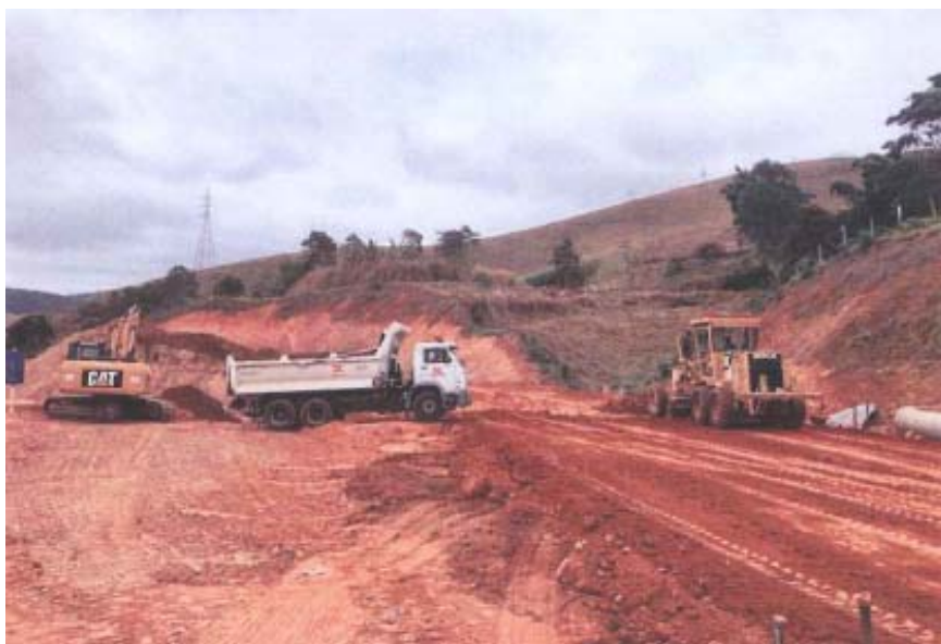
Foto 6 – Adequação da Interseção Cordeiro A - 123+300 [1]
